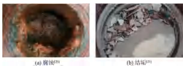
图3 管道内壁腐蚀与结垢
