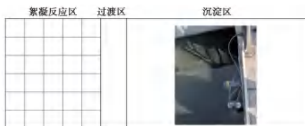
图1 絮凝沉淀池中水下摄像机的安装位置
