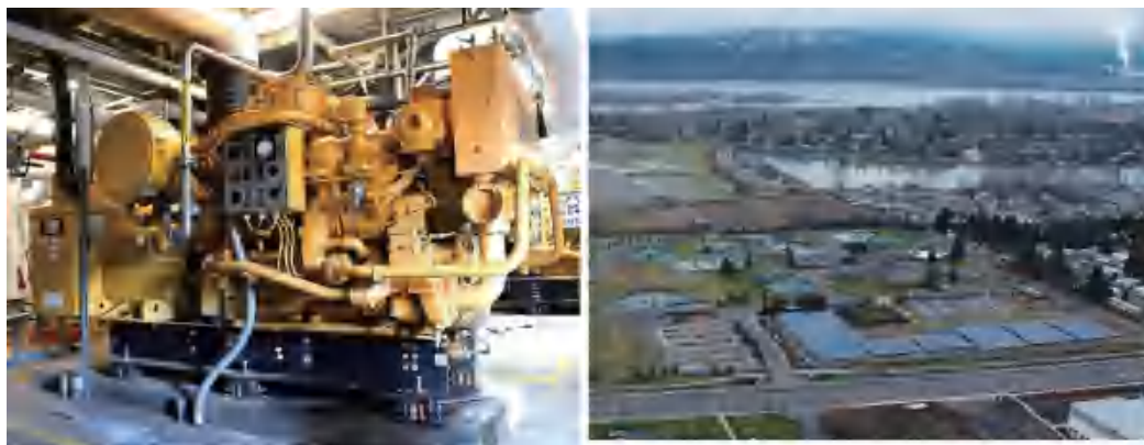
图 4 美国俄勒冈州格雷沙姆污水处理厂建设热电联产系统,通过可再生沼气热电联产和太阳能发电实现能源自给 [20]
