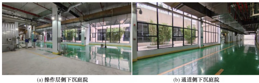
图 9 下沉式庭院与地下厂区衔接
