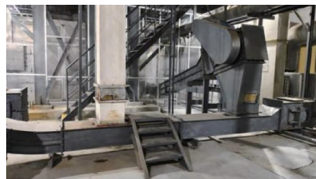
图4 刮板输送机密闭隔离与臭气泄压口现场
