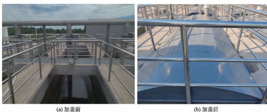
图4 反硝化深床滤池加盖密封前后现场改造
